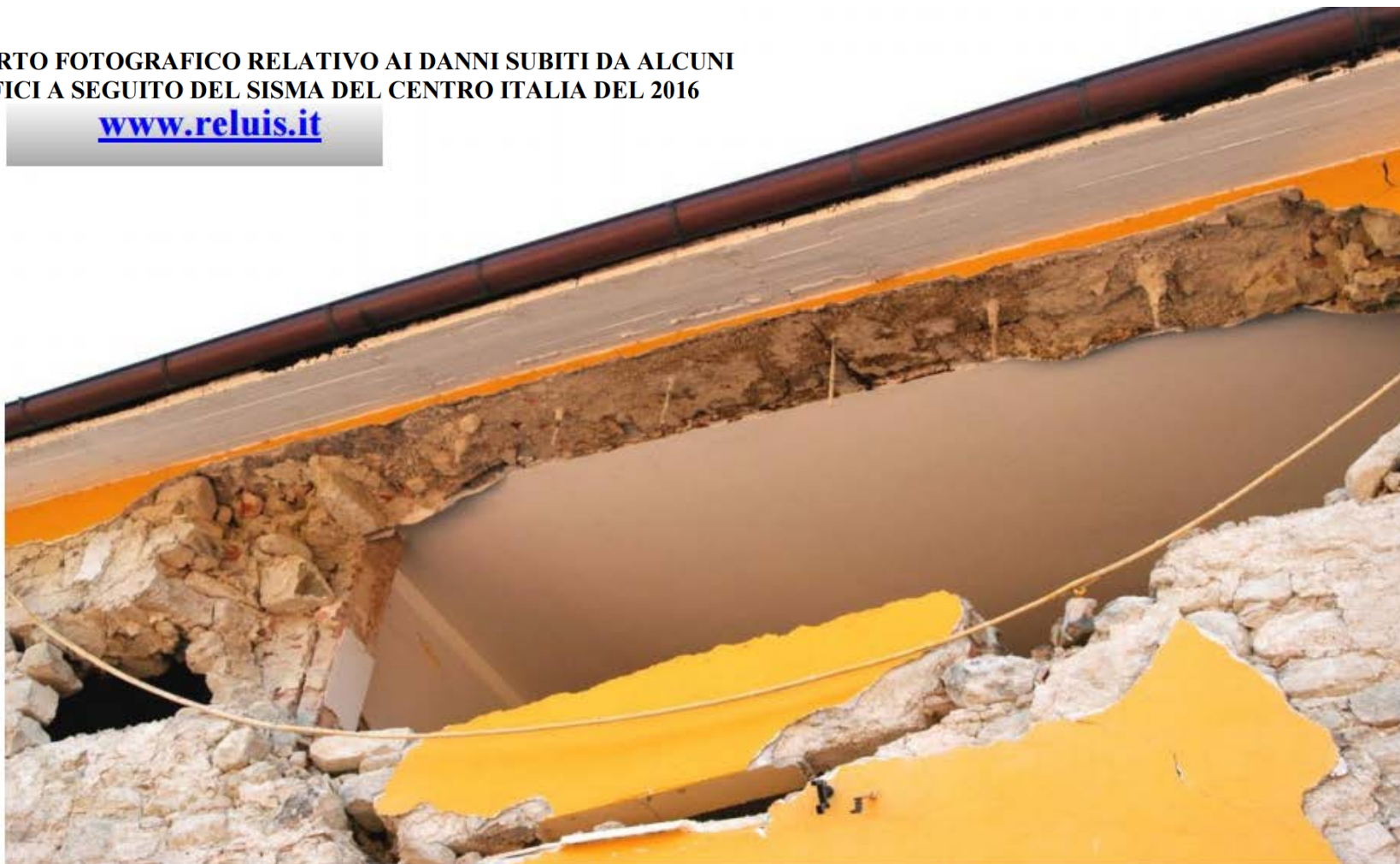
Edificio in muratura - Accumoli
